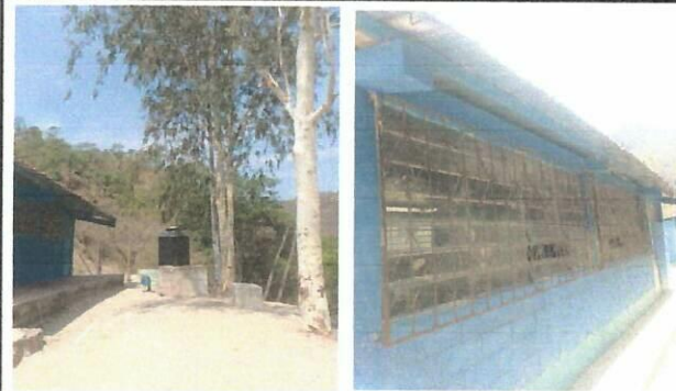
Foto 4: Foto de balcones y ventanales del lado de atrás y foto del patio se le hará mejoramiento de estructura metálica con lámina troquelada, remozamiento a balcones y a ventanales de vidrio.
