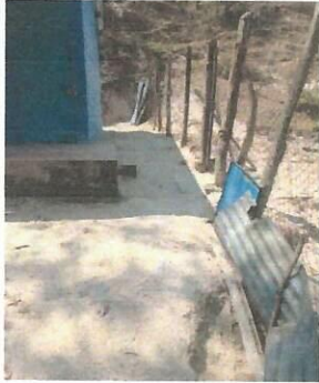
Foto 1: Foto lado derecho de la circulación, se le hará mejoramiento de la circulación perimetral.
