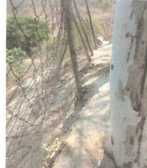
Foto 2: Foto del frente de la circulación, se le hará mejoramiento de la circulación perimetral.
